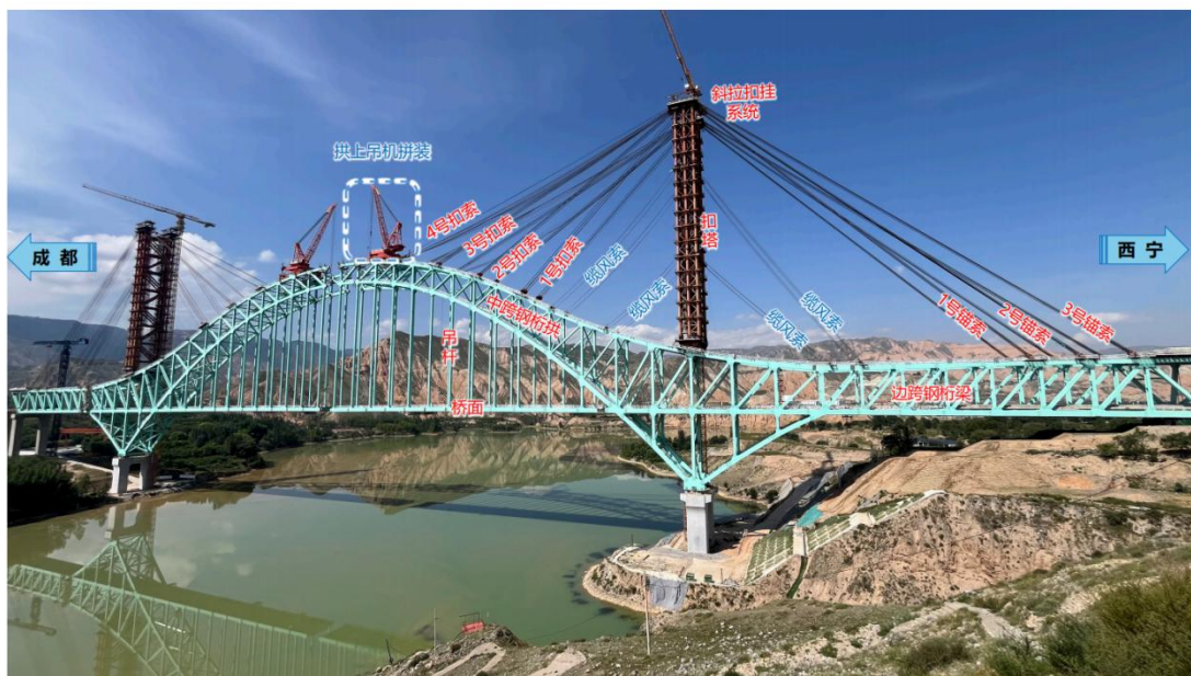
图1 斜拉扣挂系统
